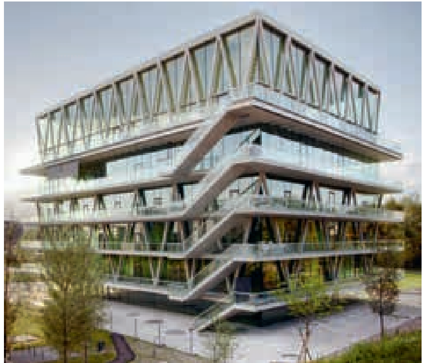
Christian Kerez' Neubau des Schulhauses Leutschenbach mit seiner filigranen Struktur und der Turnhalle im obersten Geschoss.
